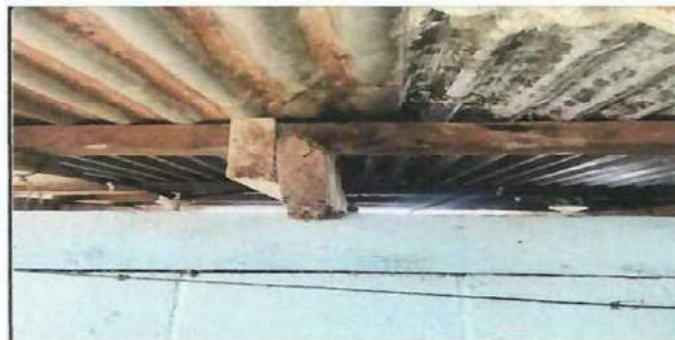
Foto 6: bigas y techo del area de baños
