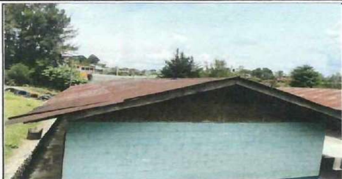
Foto1: Techo interior del modulo
